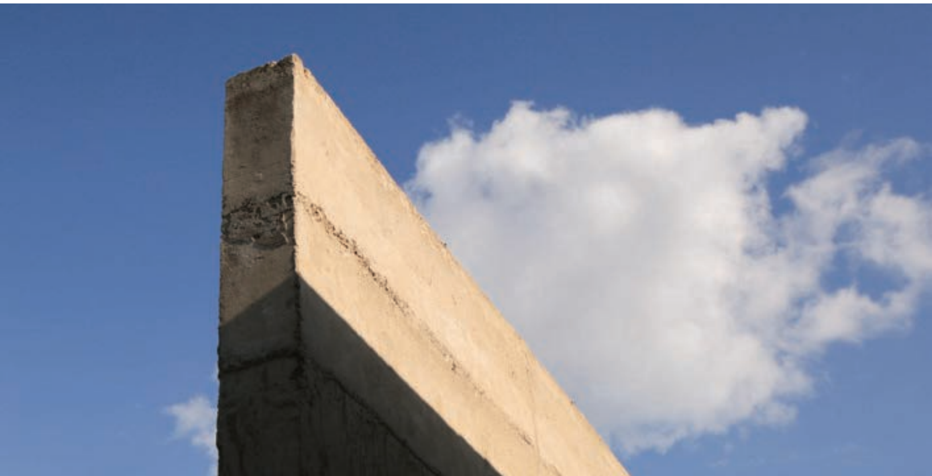
Efecto de luz sobre la estructura de la torre de concreto, en el centro del viñedo de Cuna de Tierra.
